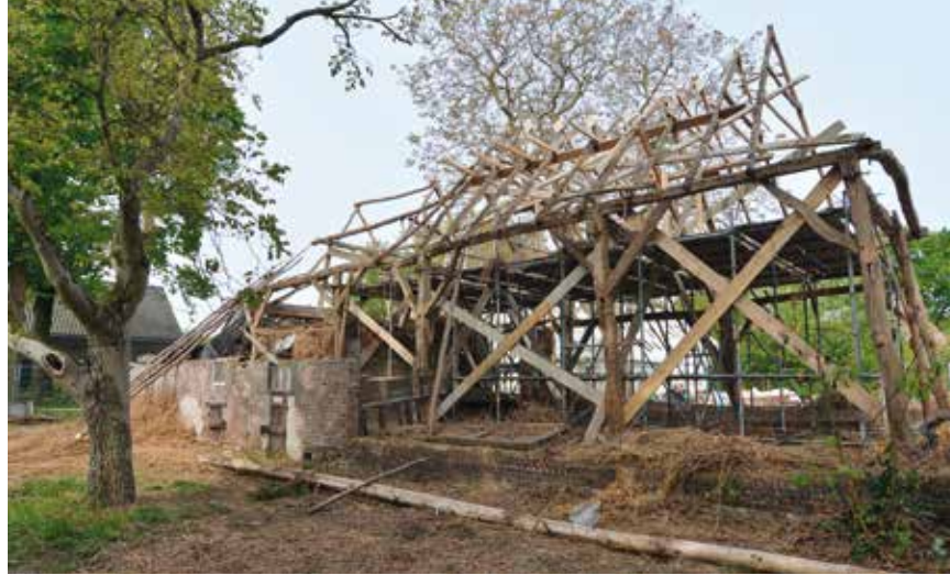
Schuur ontdaan van kap en wanden
